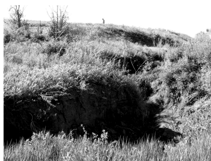
Рис. 1. Вершина донного вреза балки Быков овраг (водосбор № 22).
