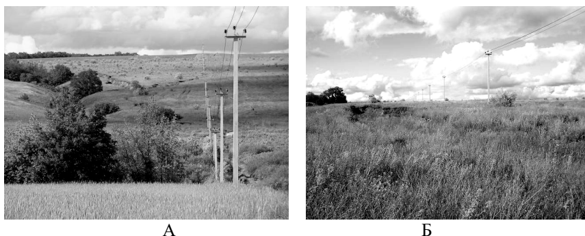
Рис. 9. А – переход действующего газопровода через балку Тарасовку с бровки левого борта; видны активные овраги и промоины на противоположном правом борту балки. Б – вершина одного из активных оврагов в 30 м к западу от технического коридора на правом борту балки.
