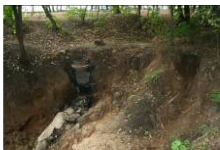
Рис. 8. Забитый мусором ливневой коллектор. (фото С.Н. Ковалёва).
