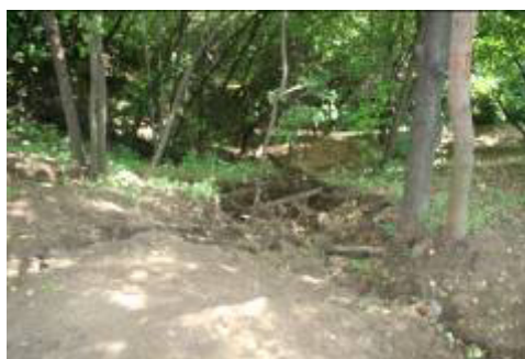
Рис. 10. Размыв в третьем левом отвершке Дьякова оврага. (фото С.Н. Ковалёва)
