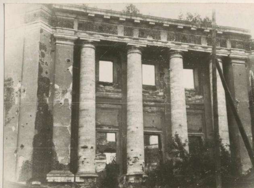
6. Усадебный дом. Портик северного фасада.
