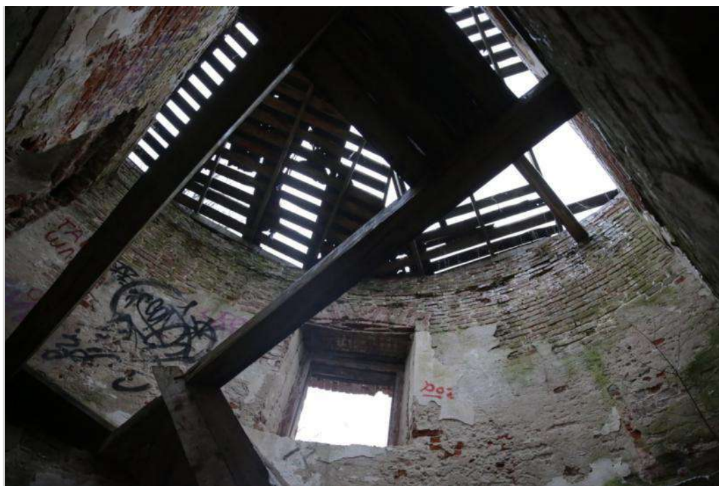
Рис. 18. Крыша Юго-Восточного флигеля усадебного комплекса 67
