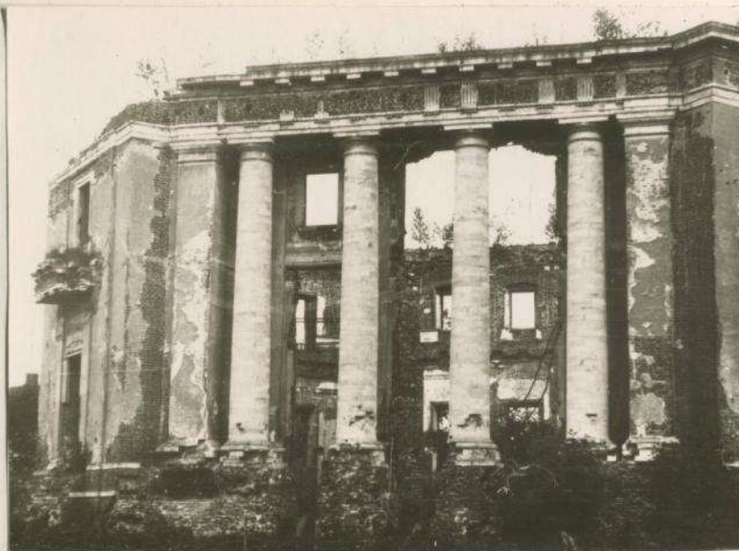
5. Усадебный дом. Южный фасад.
