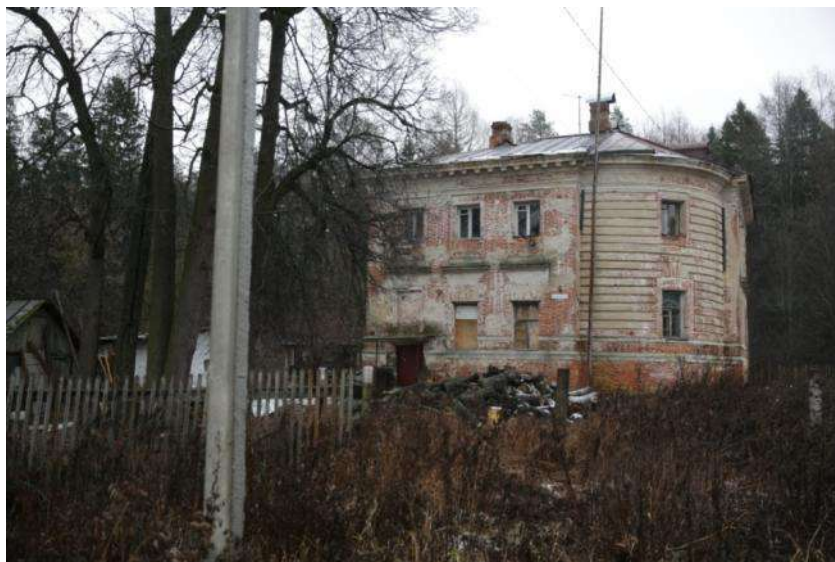
Рис. 16. Жилой Северо-Восточный флигель 65
