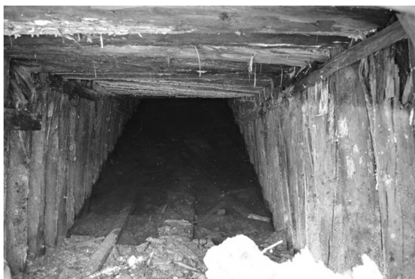
Рисунок 2 – Мыс Раздельный. Рудник. Вход в штольню
