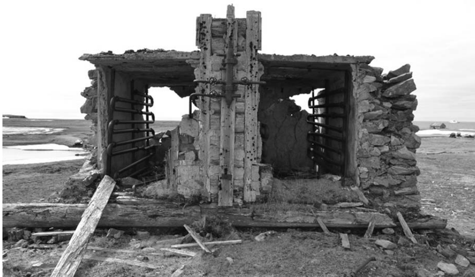
Рисунок 2 – Осушительное сооружение с трубами
